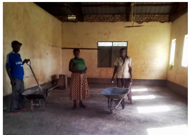
Alle packen mit an - Renovierung des Schlafsaals
