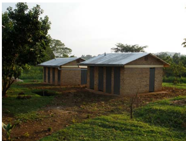
Waschräume und Latrinen
