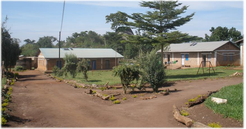
2015: Blick auf das Hostelgelände mit Jungen- und Mädchenschlafsaal. Nicht sichtbar sind Speisesaal, Küche, Ställe, Klassenzimmer, Wassertanks, Toilettenanlagen und Workshop.
