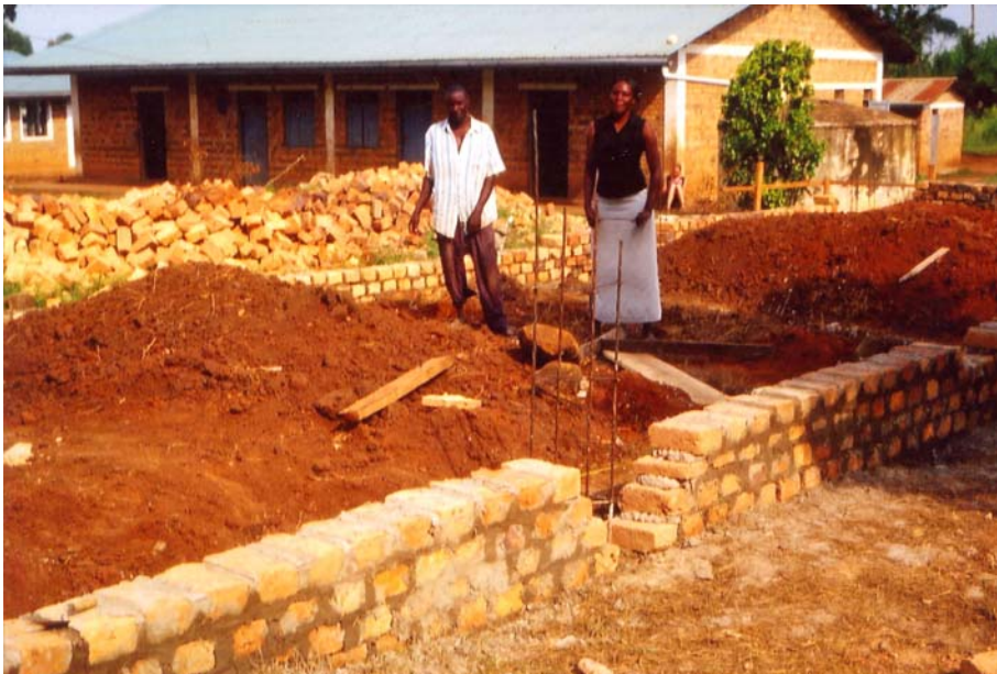
Zwei zusätzliche Schlafräume entstehen. (Aufnahme Juli 2009: B. Kalt)
